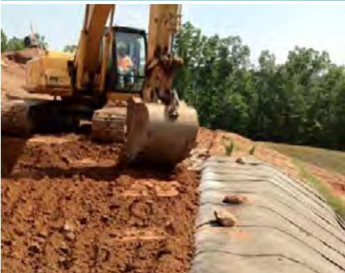
El Manto se ancla en la parte superior e inferior del talud para luego ser cubierto con material.
