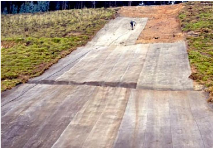
Cortes a la medida del manto en sitio. Se despliega en tres secciones.
