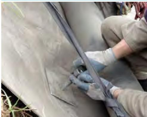
Se utilizaron platinas de 200 x 200mm para asegurar el CC a la cara del talud.
