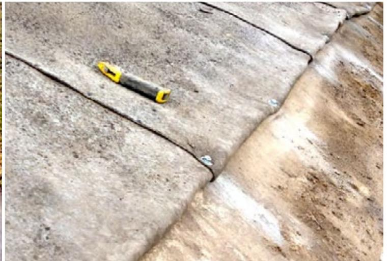
Fijación del manto de hormigón con chazo expansivo a la cuneta de pata.
