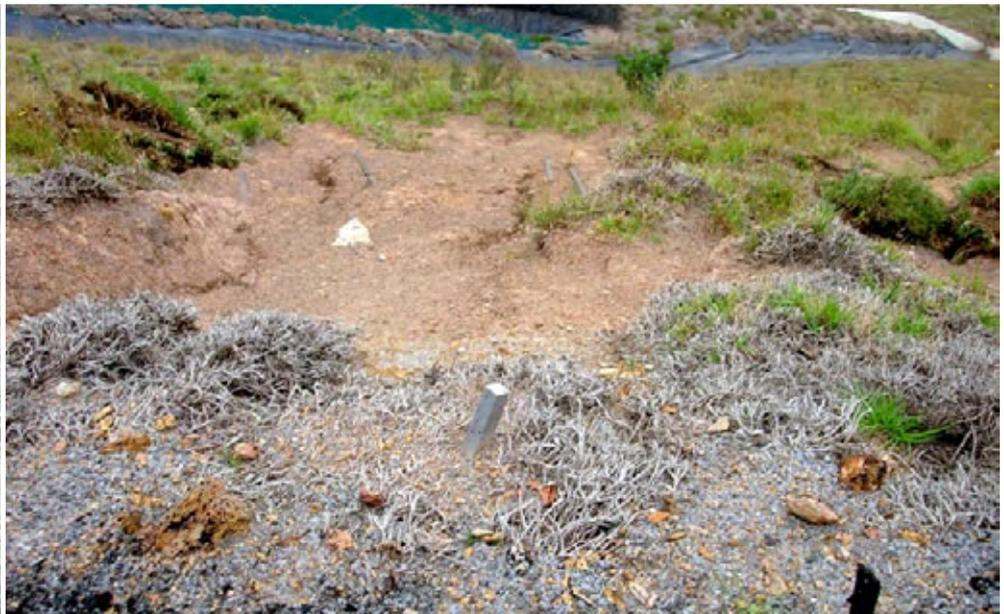
Se evidencia erosión a causa de la lluvia en una sección del talud generando un potencial riesgo en la vía principal.
