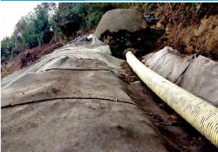
Fijación del CC en la corona del talud con anclajes metálicos.
