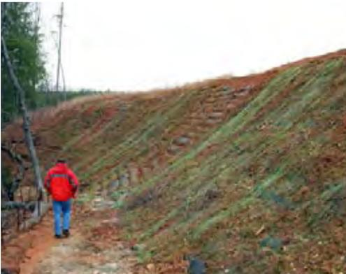
Control de erosión y estabilidad del talud usando geo-textil.
