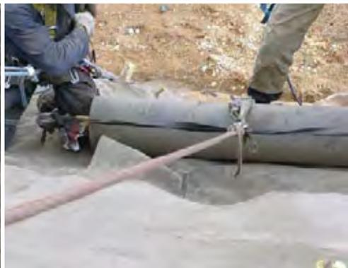
Despliege del CC a través de un sistema de polea permitiendo un rendimiento de 80m2/día.
