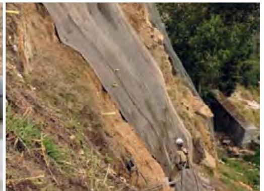
Se instalaron anclajes de contención y drenajes subhorizontales antes de instalar el CC.
