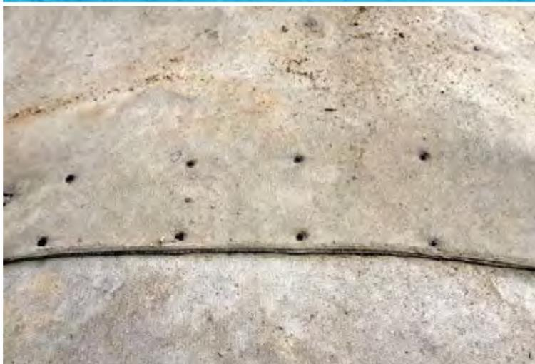
Fijación del manto con doble tornillería cada 20cm
