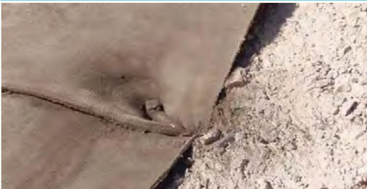
Se Utilizaron Anclajes asegurando cada Extremo del Manto
