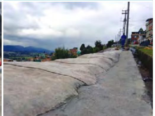
Se aseguro el CC en la corona del talud mediante un vaciado de concreto a lo largo de una zanja.
