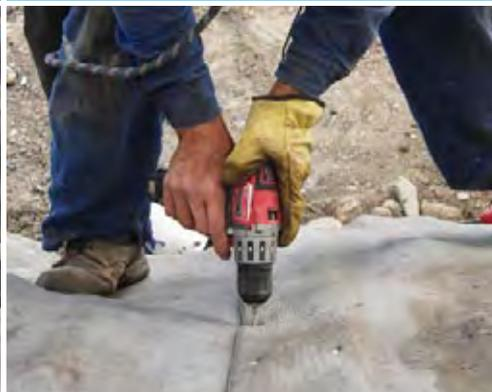
Se traslapo el manto con un mínimo de 10cm y se fijaron con tornillo autopercutor en intervalos de 200mm.
